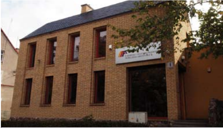
Siedziba funduszu „Poręczenia Kredytowe” w Działdowie
